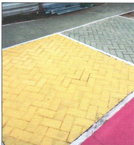
FOTO - 12 - PINTURA ACRILICA EM PISO CIMENTADO DUAS DEMAOS
