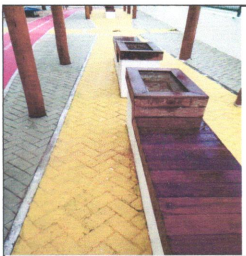
FOTO - 14 - Assentamento de peças de eucalipto tratado, d=19 a 22cm para confecção de pergolado (ref:obra Sergipetec)
