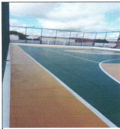
FOTO - 02 - PINTURA ACRILICA DE FAIXAS DE DEMARCAÇÃO EM QUADRAPOLIESPORTIVA, 5 CM DE LARGURA
