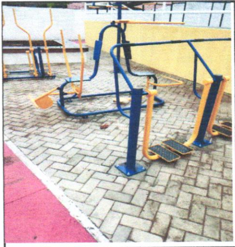
FOTO - 05 - INSTALAÇÃO DE SIMULADOR DE CAVALGADA TRIPLO, EM TUBO DE AÇO CARBONO - EQUIPAMENTO DE GINÁSTICA PARA ACADEMIA AO AR LIVRE
