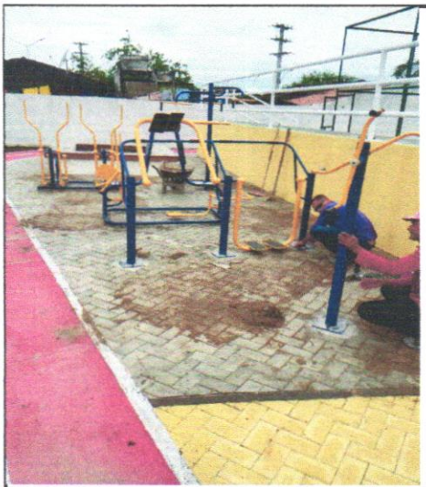
FOTO - 29 - INSTALAÇÃO DE ESQUI TRIPLO, EM TUBO DE AÇO CARBONO - EQUIPAMENTO DE GINÁSTICA PARA ACADEMIA AO AR LIVRE
