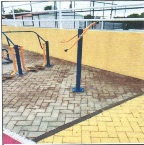
FOTO - 06 - INSTALAÇÃO DE MULTIEXERCITADOR COM SEIS FUNÇÕES, EM TUBO DE AÇO CARBONO - EQUIPAMENTO DE GINÁSTICA PARA ACADEMIA AO AR LIVRE
