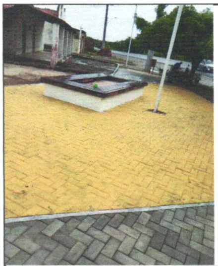
FOTO - 19 - Assentamento de peças de eucalipto tratado, d=19 a 22cm para confecção de pergolado (ref:obra Sergipetec)
