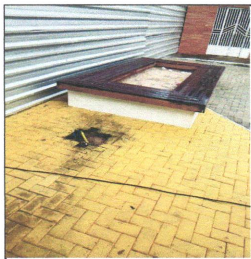
FOTO - 16 - Assentamento de peças de eucalipto tratado, d=19 a 22cm para confecção de pergolado (ref:obra Sergipetec)
