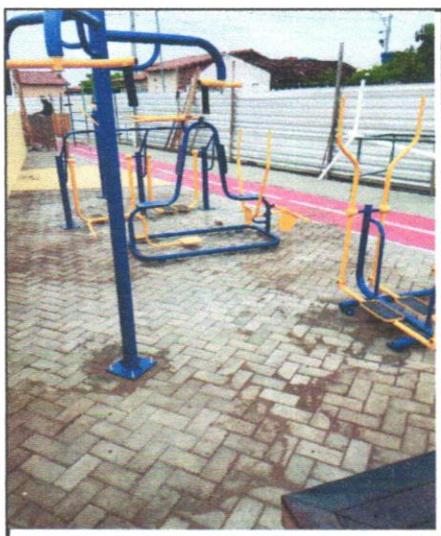
FOTO - 25 - INSTALAÇÃO DE ALONGADOR COM TRÊS ALTURAS, EM TUBO DE AÇO CARBONO - EQUIPAMENTO DE GINÁSTICA PARA ACADEMIA AO AR LIVRE / ACADEMIA DA TERCEIRA IDADE -
