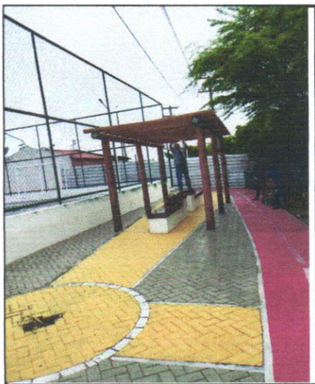
FOTO - 17 - Assentamento de peças de eucalipto tratado, d=19 a 22cm para confecção de pergolado (ref:obra Sergipetec)
