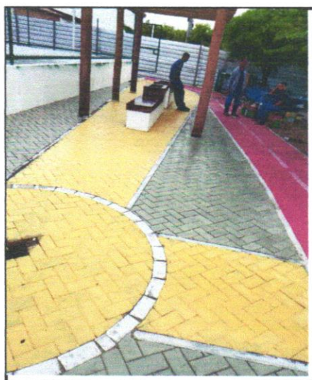
FOTO - 27 - PINTURA ACRILICA EM PISO CIMENTADO DUAS DEMAS
